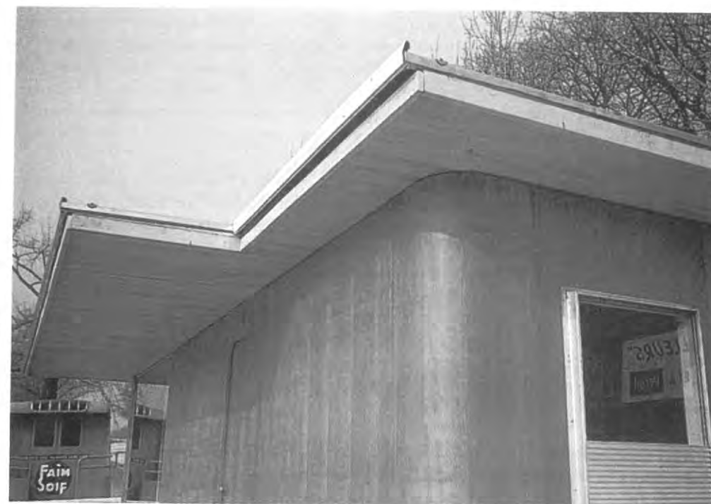
Figure 6. Maison des Jours Meilleurs , Paris 1956. View of the corner panel and roof panel. (© Centre Pompidou, Bibliothèque Kandinsky)
